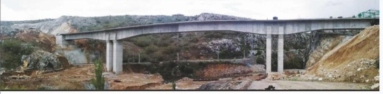
AKYAZI / DOKURCUN • DENGELİ KONSOL KÖPRÜ
